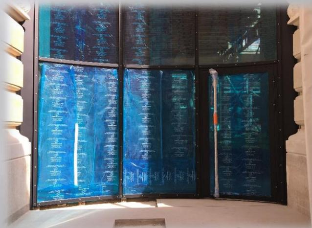
Menuiseries extérieures en acier courbe à rupture de pont thermique
